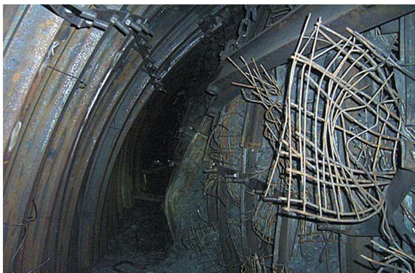
Результат крупного сейсмоявления на шахте «Комсомольская», 2011 год. Шестиметровой ширины выработка схлопнулась за несколько секунд, оставив лишь полметра свободного пространства. Никто не пострадал
